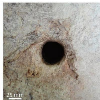
Fig. 9 : Partie supérieure d'une excavation ouverte sur le versant nord de la Butte de Moncoué avec front de taille révélant des trous de foration verticaux en coupe [▼]. Détail : trou de foration vertical abandonné (photos : Didier Poncet).
